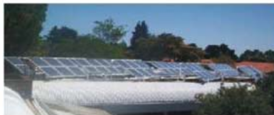
Colectores solares en Parque de Vacaciones Ute - Antel, Minas - Uruguay, superficie total de paneles: 90 m². Foto: A. Baroni
