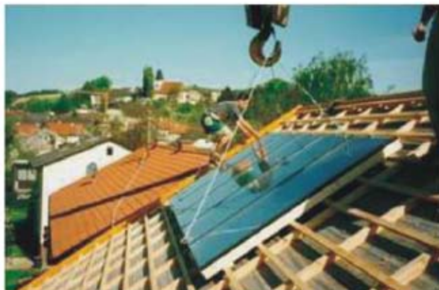
Integración al cerramiento superior de una vivienda. Fuente: Estif
